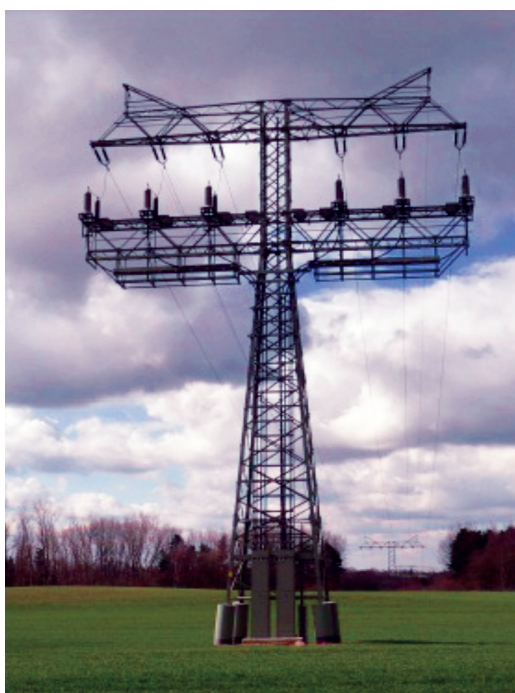
Bild 5. Übergangsmast für zwei 110-kV-Systeme
