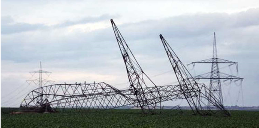
Abb. 6.3 : Windhose knickt fünf 380-kV-Masten in Thüringen am 14. August 2015
