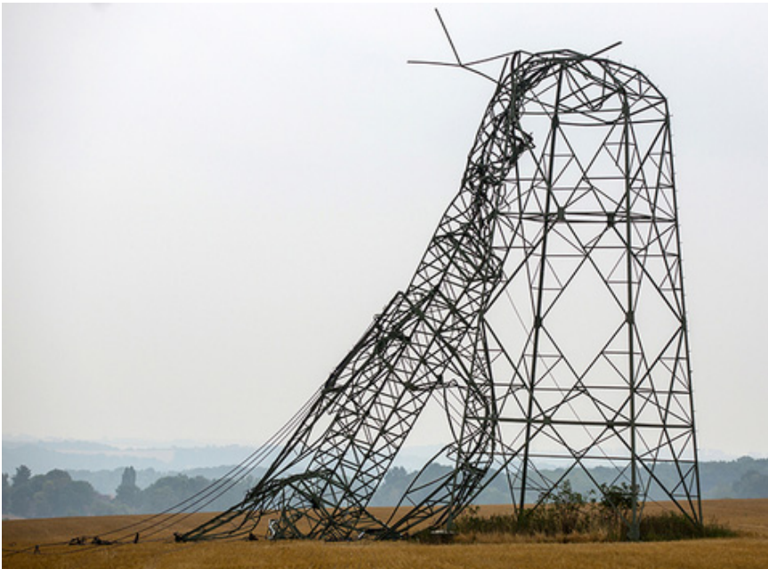
Abb. 6.3 : Windhose knickt fünf 380-kV-Masten in Thüringen am 14. August 2015
